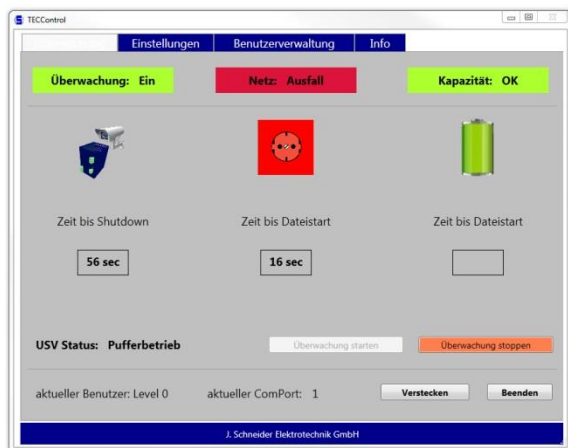
Die USV meldet einen Netzausfall
